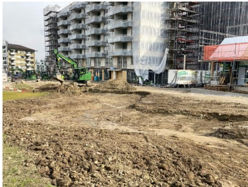
Vorarbeiten für die Bachausdöhlung
