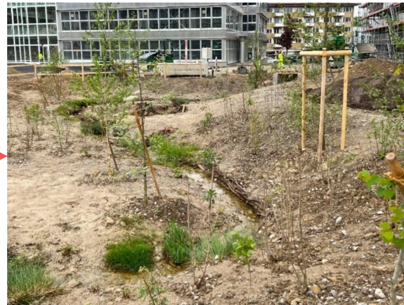
Anlage neues oberirdisches Bachbett
